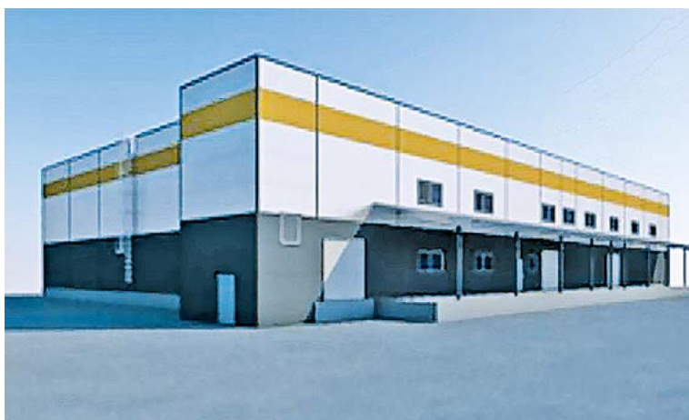
Здание склада-холодильника с офисными помещениями площадью 2500 м 2
