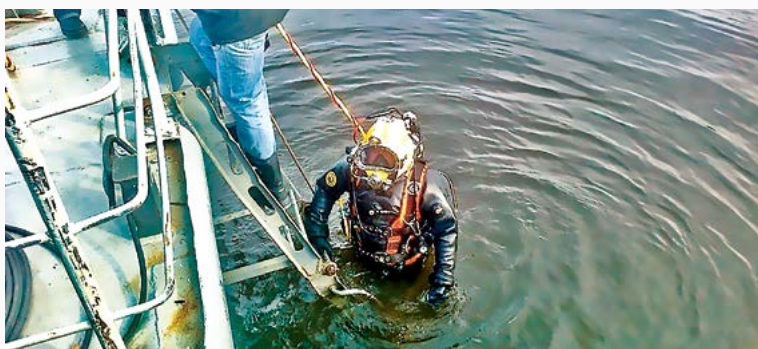
Причал № 9 морского порта «Большой порт Санкт-Петербург»
