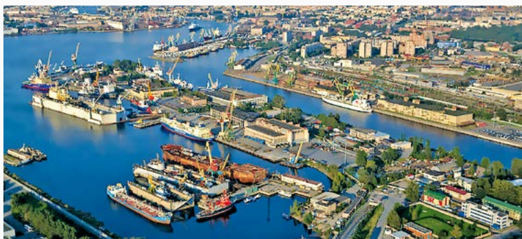
Причал № 33 морского порта «Большой порт Санкт-Петербург»
