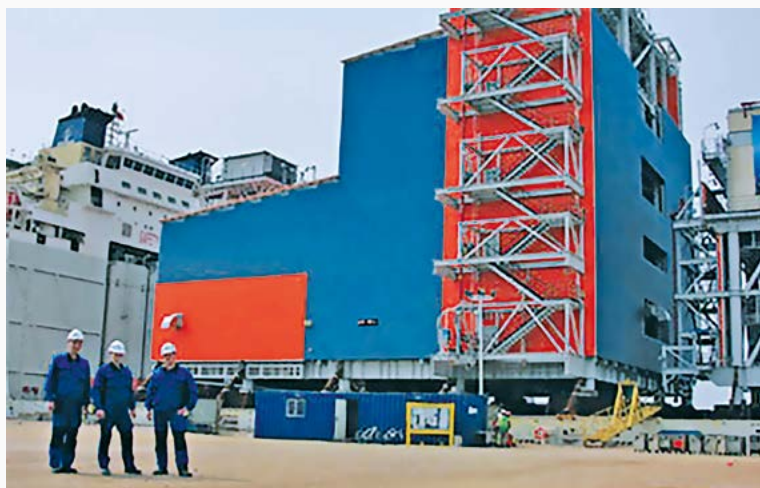
Завод «Ямал СПГ»
