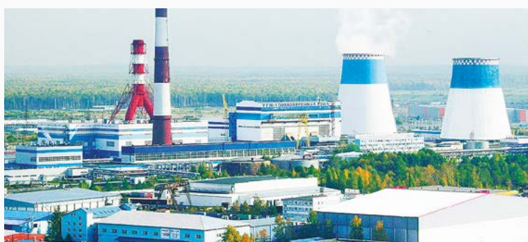
Правобережная ТЭЦ ПАО «ТГК-1»
