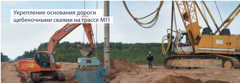
Установка щебеночных свай с помощью виброфлота
