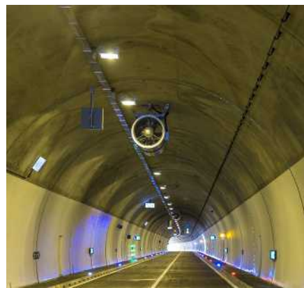
Безопасность пользования туннелями благодаря защите от перенапряжений
