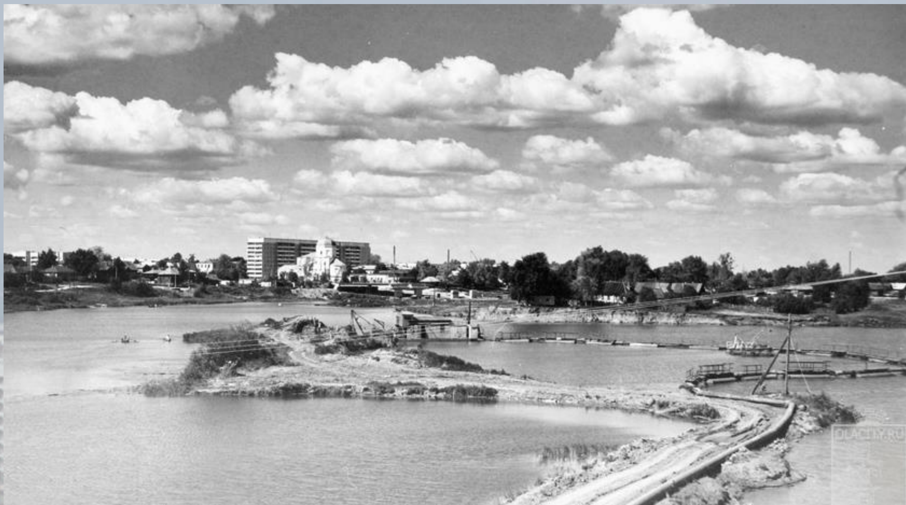
Намыв грунта на реке М. Кокшага. Земснаряд подошел практически вплотную к Заречной слободе. Строится Вознесенский мост. Фото Е. Зеленко, 1987 г.
